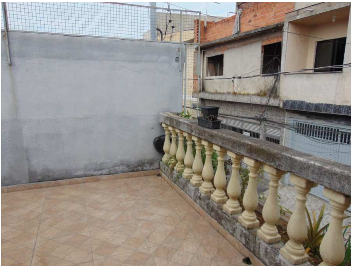
VISTA PARCIAL DA LAJE DA GARAGEM DO REQUERIDO.
