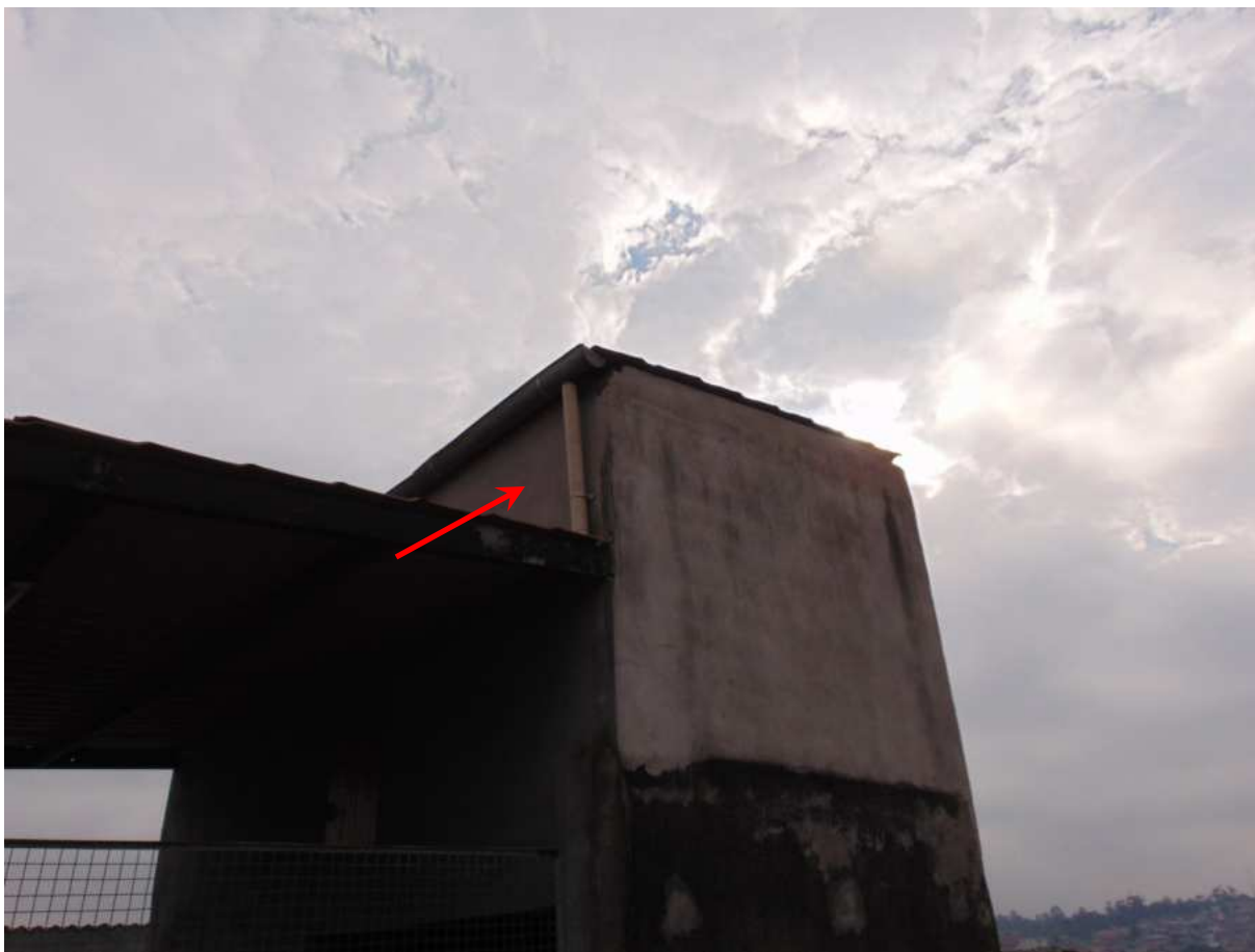
DETALHE DA TUBULAÇÃO DE COLETA DE ÁGUAS PLUVIAIS DO REQUERIDO, VISTA DO IMÓVEL DOS AUTORES.
