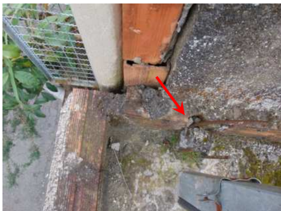
PONTOS DE INFILTRAÇÕES PELAS ESPERAS DE ARMADURAS
