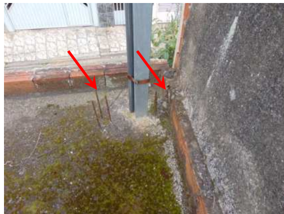
PONTOS DE INFILTRAÇÕES PELAS ESPERAS DE ARMADURAS
