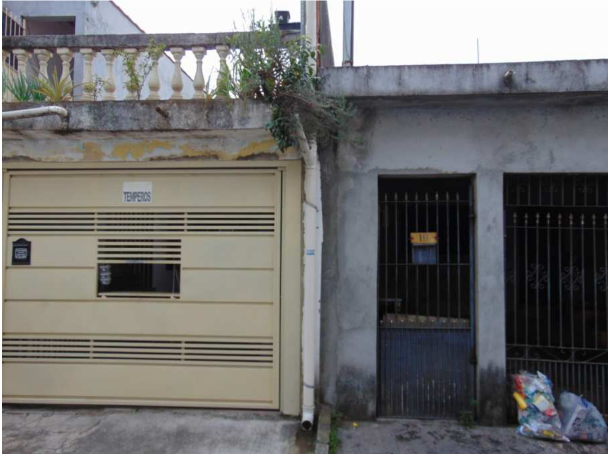
DETALHE DAS PAREDES DAS GARAGENS DAS PARTES.
