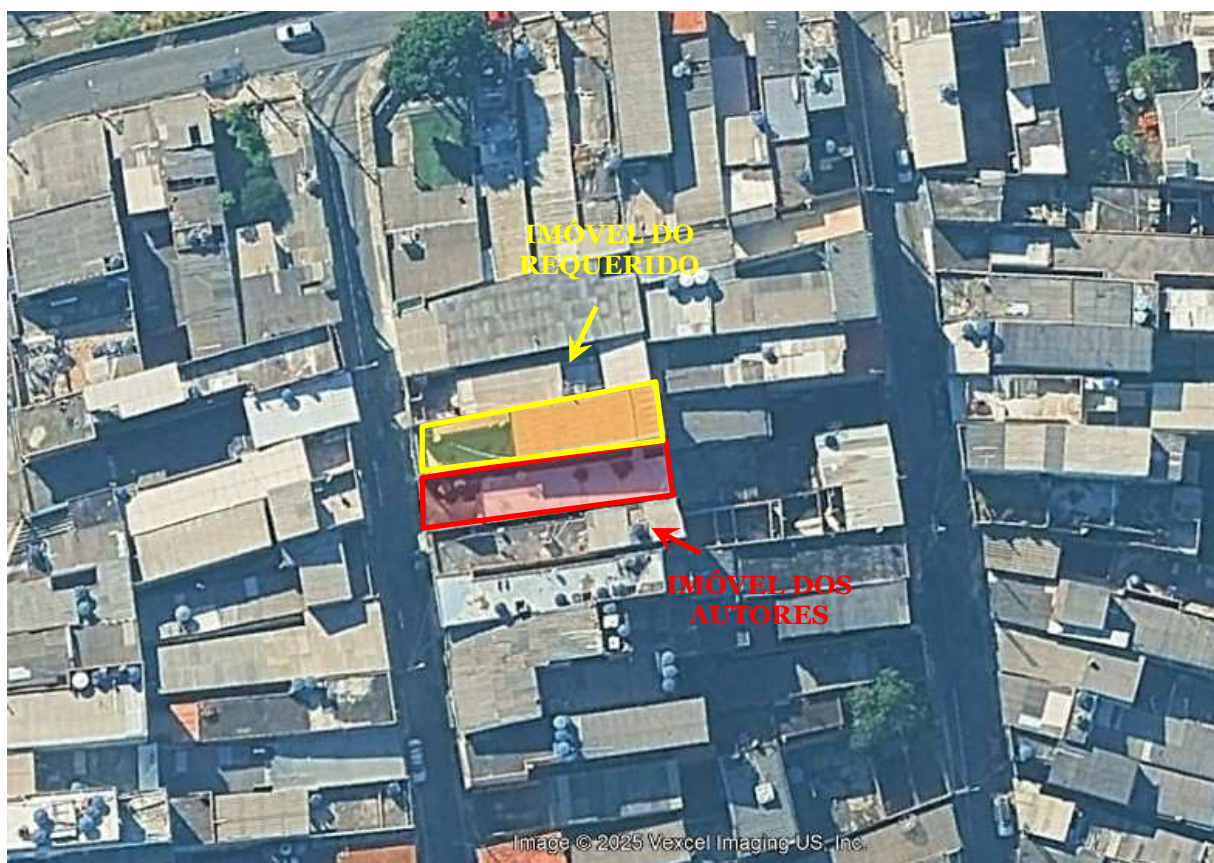
FOTOGRAFIA AÉREA COM A LOCALIZAÇÃO DO IMÓVEL DOS AUTORES E DO REQUERIDO.
